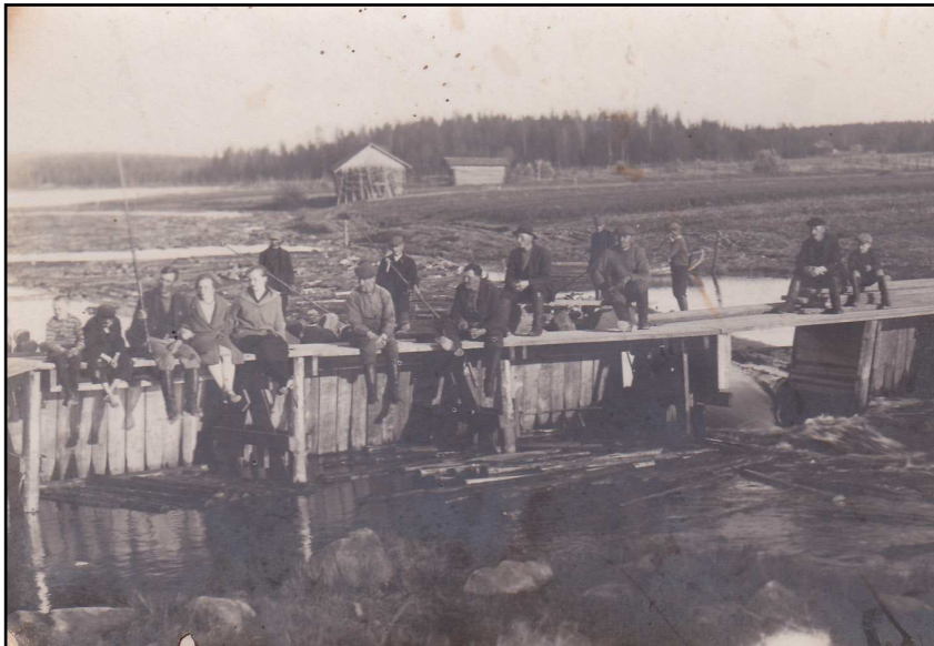
Tukinuiton aikainen pato rakennusvaiheessa ja uittomiehiä padolla Koluskoskella (kuvat: E. Pajula).
